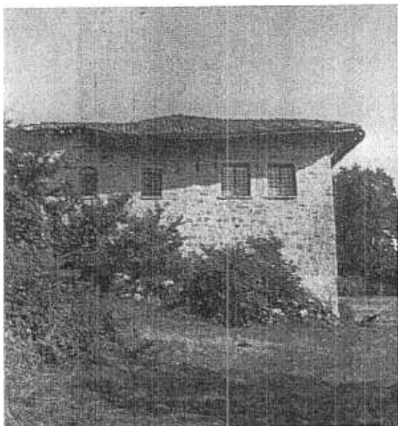
2. Arbanassi. Ancienne maison du type fermé.
