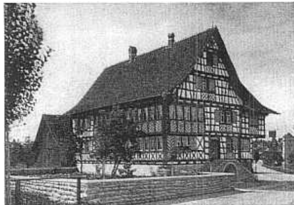
Oberaach. Après la restauration.
