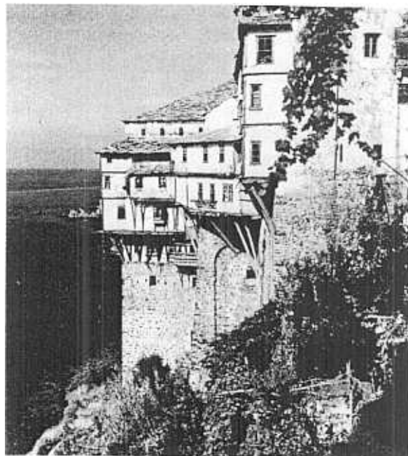
Fig. 13. — Détail d'une aile de monastère au Mont Athos : combinaison de formes traditionnelles de l'habitat vernaculaire de la Macédoine avec les socles massifs de l'enceinte fortifiée.
