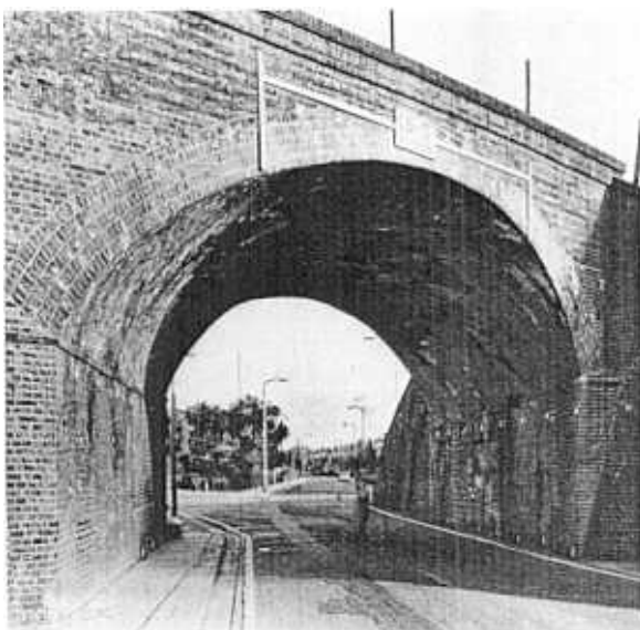
Fig. 7 - Pont d'Epsom (Grande-Bretagne) (vers 1860). Les profils indiqués par des marques blanches ont été relevés photogrammétriquement en vue de travaux de consolidation.
