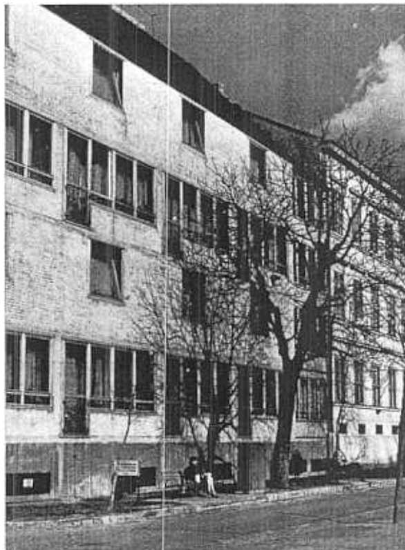
Fig. 5. — Budapest I, rue Uri 38 et Promenade Toth Arpad, maison d'habitation. Architectes: György Janossy et Jozsef Hrecska, 1967.
