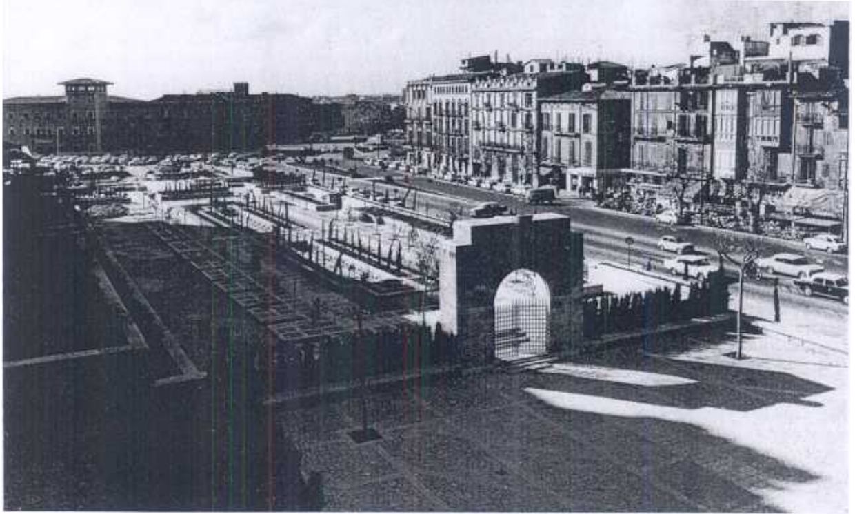
Fig. 11. — Ensemble des nouveaux jardins pendant les travaux. A l'avant-plan, le portail du xv e siècle (avec armoiries du xvii e siècle) provenant du mur démoli pour réouvrir le grand arc.
