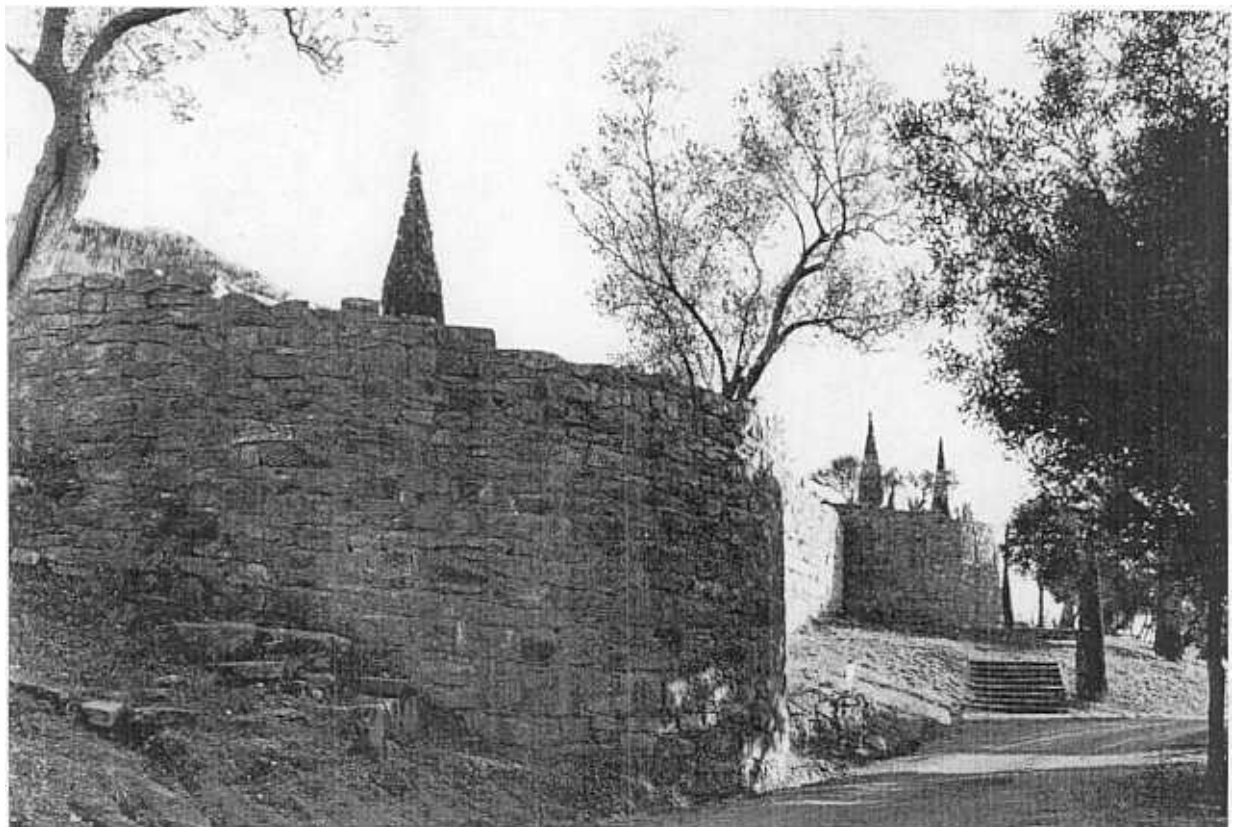
Enceinte fortifiée versant occidental
