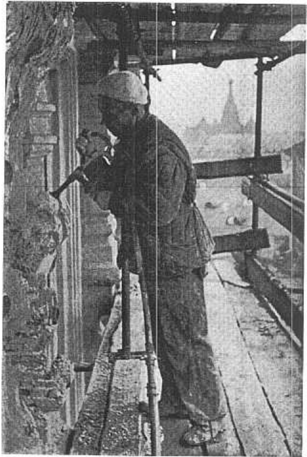
Fig. 7. — Injection dans la maçonnerie d'une cathédrale ancienne de Russie.
