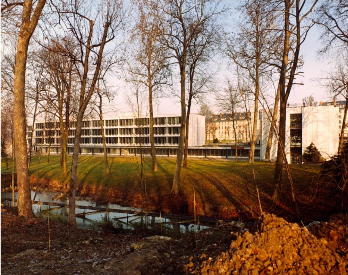
DR (droits réservés). Fonds Zehrfuss. Académie d'architecture/Cité de l'architecture et du patrimoine/Archives d'architecture du XXe siècle
