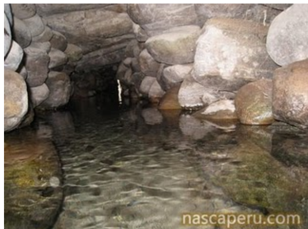
Figure 9 Galería filtrante. Nasca. Mintur (Ministerio de Industria, Turismo y Comercio Exterior del Perú), 2009.
