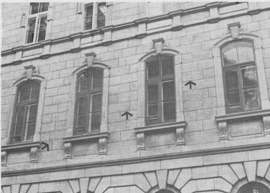
Vue rapprochée d'une partie de la façade principale: l'effet de taches y est perceptible, et il dénote une certaine retenue exercée, lors du ravalement, pour ne pas endommager la taille de la pierre et son support, le calcin.
