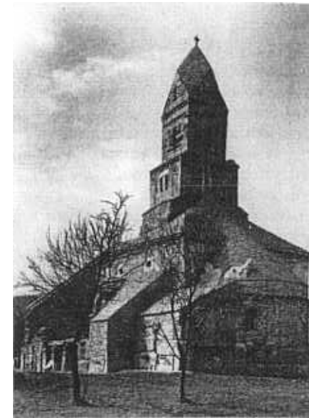
Fig. 2 - Romania. La chiesa di Densus dopo il restauro.
