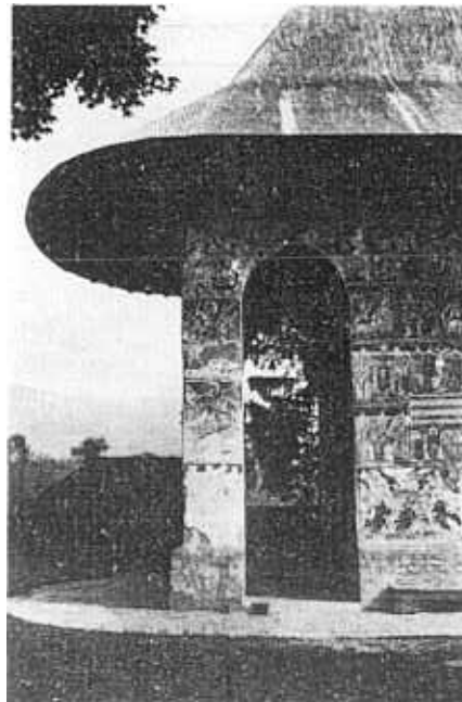
Fig. 4 - Romania. La chiesa del Monastero Humor (1532) dopo il restauro.
