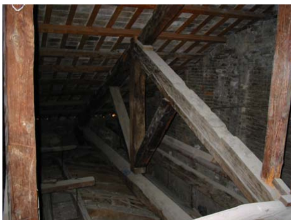
Figure 2. The trusses (N. Lombardini, 2007)
