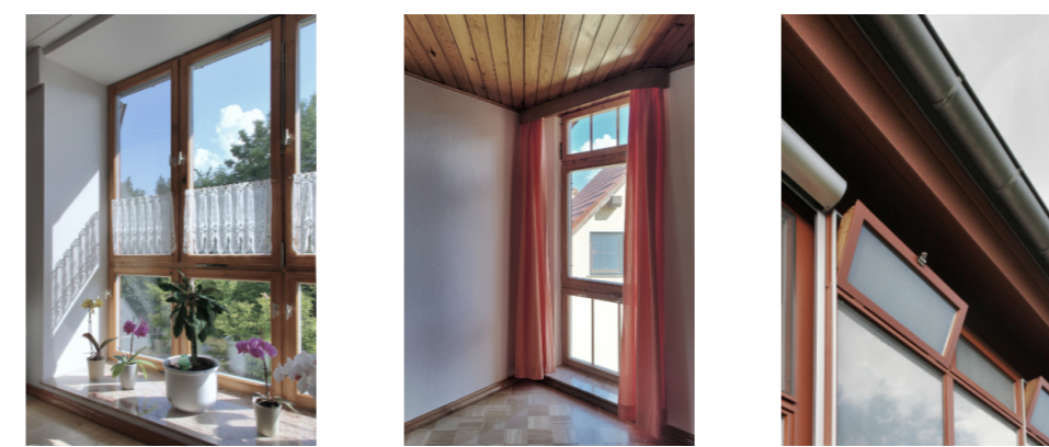
Abbildung 8: Detailaufnahmen [l] Laibung Sonnenwand [m] Rissalit [r] Lüftungsklappen
