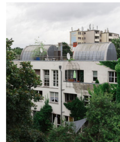
Abb. 9: Gebäude von Patschan-Werner-Winking vor Sanierung, 2017
