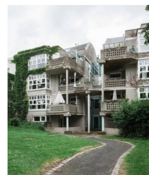
Abb. 7: Gebäude von Hertzberger vor Sanierung, 2017
