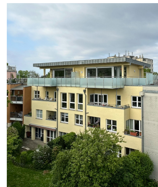
Abb. 10: Gebäude von Patschan-Werner-Winking vor Sanierung, 2023
