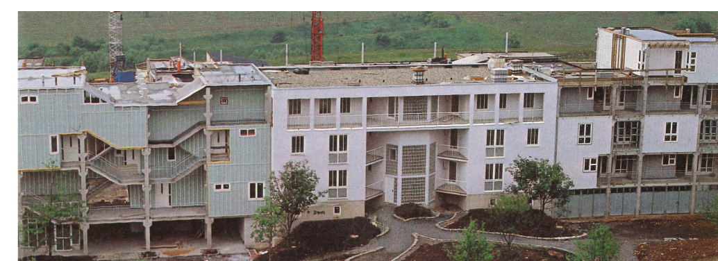
Abb. 12: Luftbild aus der Bauphase, 1982
