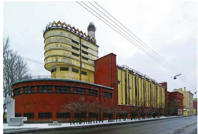
Die Energiestation der Industrieanlage „Rote Fahne“ in St. Petersburg von Erich Mendelsohn.
