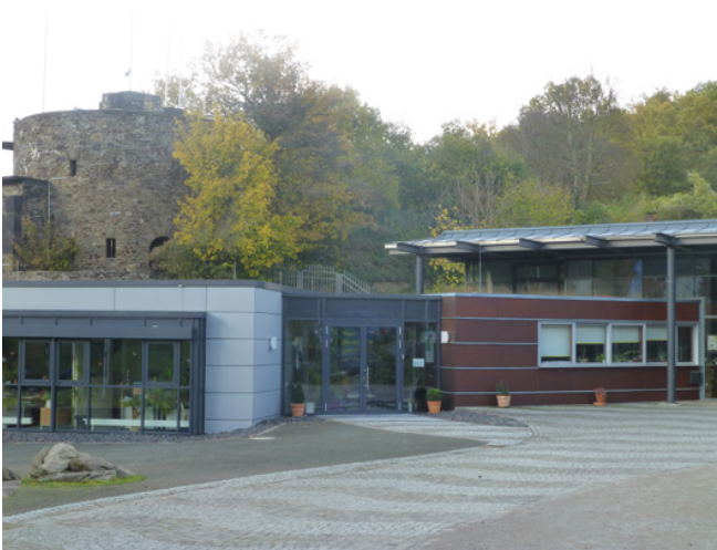
Der Neubau des Besucherzentrums Loreley, eröffnet im Mai 2000.
