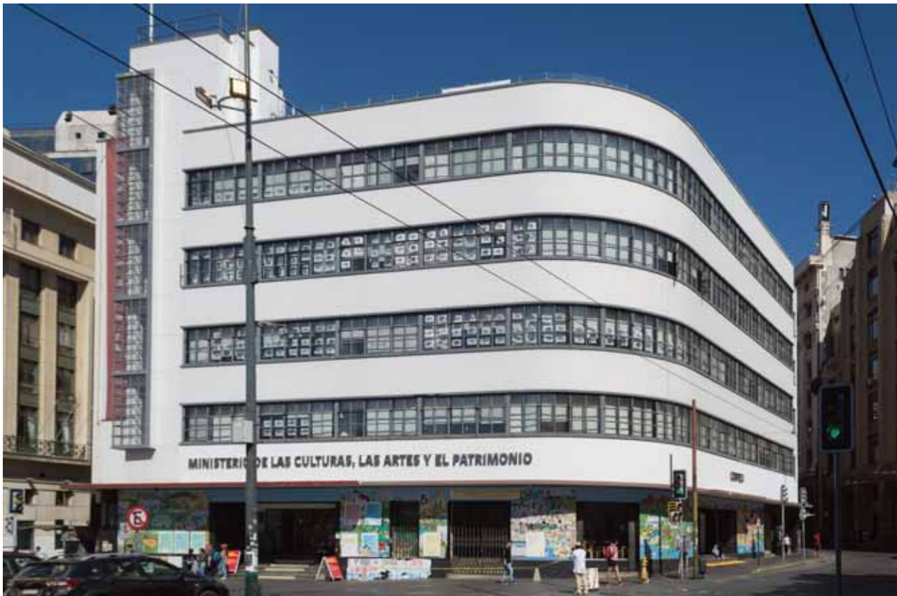
Fig. 11 Valparaíso, Edificio del Ministerio de las Culturas, las Artes y el Patrimonio (Edificio del Ex Correo)
