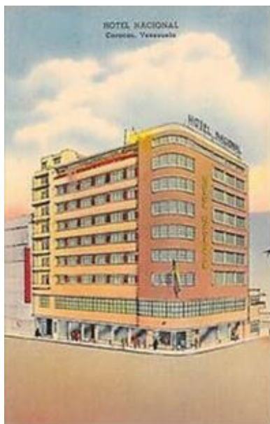
Figura 12: Hotel Nacional (Demolido), Caracas, Dto. Capital. Fuente: Del Campe.net
